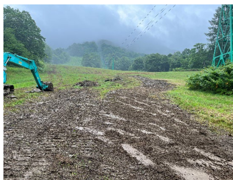
ファミリーコース暗渠排水工事
