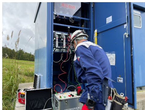
リフト 高圧電気設備点検
