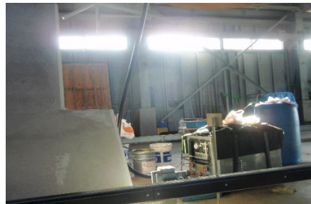
ゴンドラオイル交換
