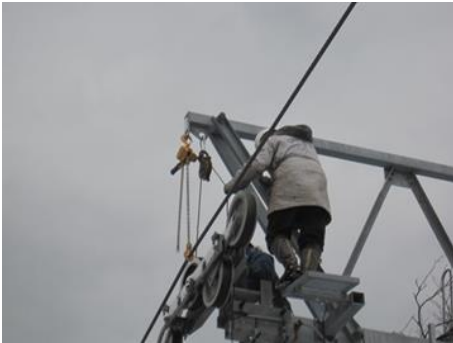
リフト索輪交換
