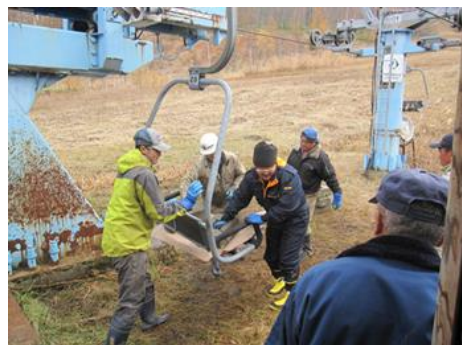
リフト荷重試験
