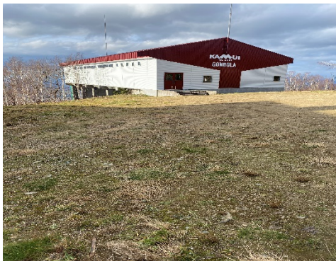
改修後山頂駅舎
