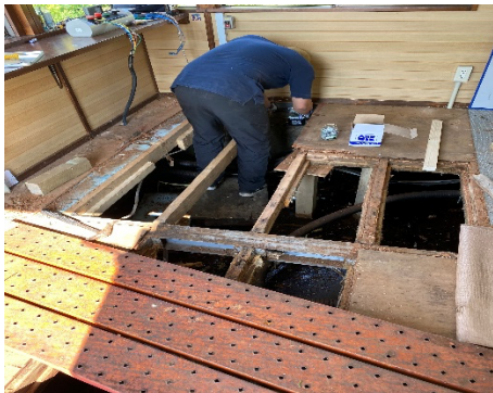
運転室床整備
