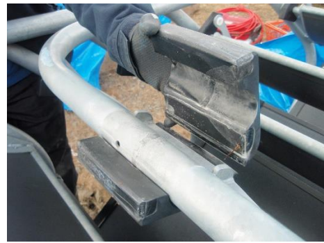
ペアリフト緩衝ゴム点検
