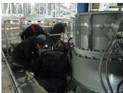
ゴンドラ予備原動機操作方法訓練
