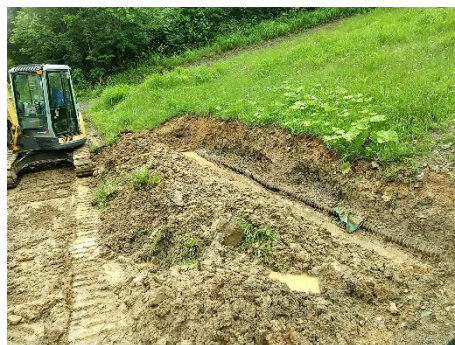
初心者コース暗渠排水工事
