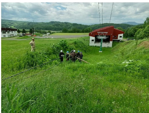
支曳索切り詰め作業
