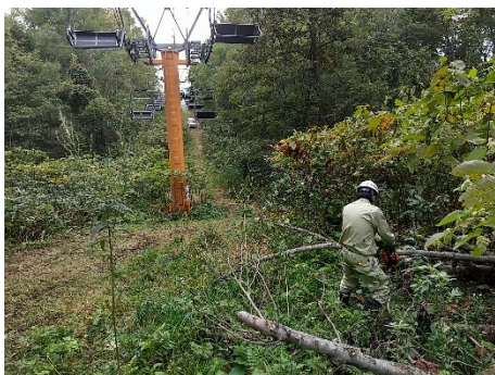
リフト索道敷支障木伐採
