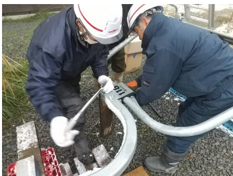
リフト搬器整備
