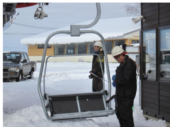
第1ペアリフト荷重制動試験
