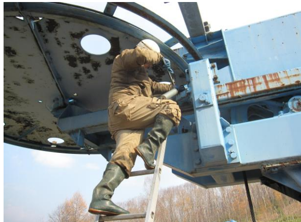
第5ペアリフト給油作業
