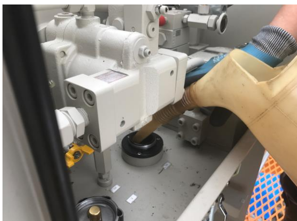
第4ペアリフト油圧緊張作動油交換
