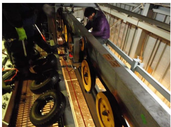
ゴンドラ押送装置点検
