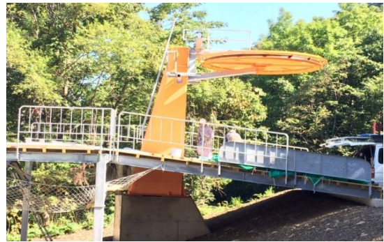
第4リフト山頂停留場機械装置更新
