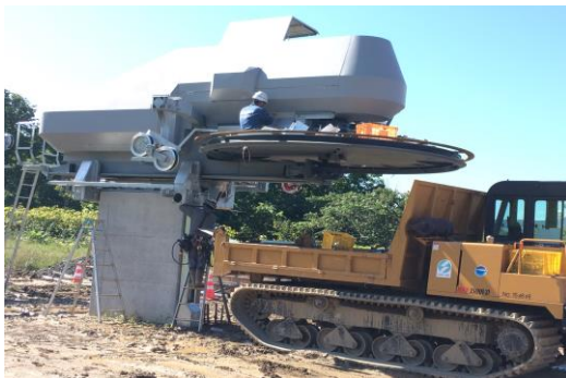
第1リフト山麓停留場機械装置更新
