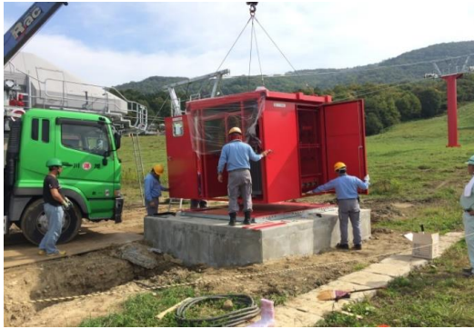
屋外キュービクル更新
