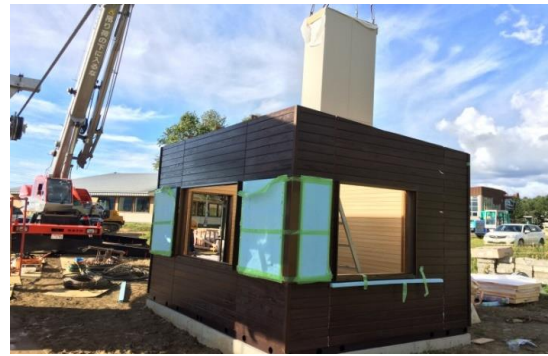
リフト運転室更新
