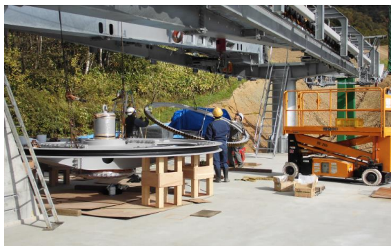
山麓停留場機械装置更新②
