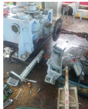
第1リフト常用ブレーキ分解整備
