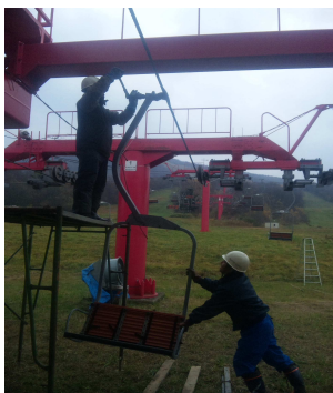
リフト搬器取付作業
